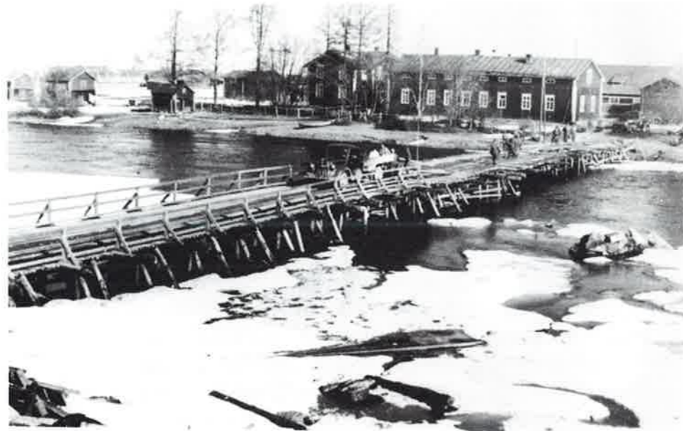
Saksalaiset tuhosivat kaikki sillat ja kohdalle osuneet rakennukset ja miinoittivat maaston. Tässä Pudasjärvellä Iijoen silta, johon suomalaiset rakensivat pukkisillan räjäytetyn tilalle. (Kuva Aimo Pitkakangas)
