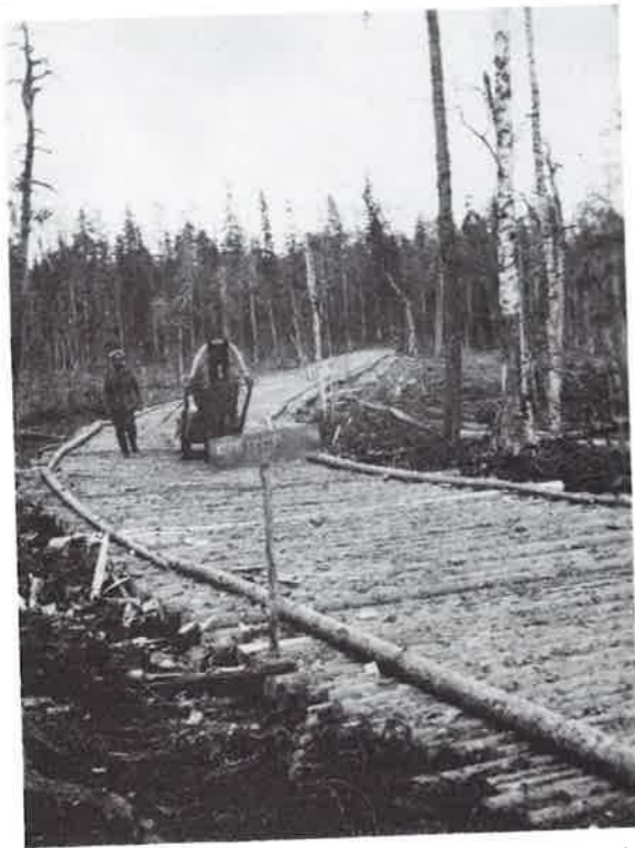
Huoltotie Hevosenkengään, ns. Tönkyrän silta. Autoillakin sitä ajettiin. (Kuva Väinö Ylitalo)
