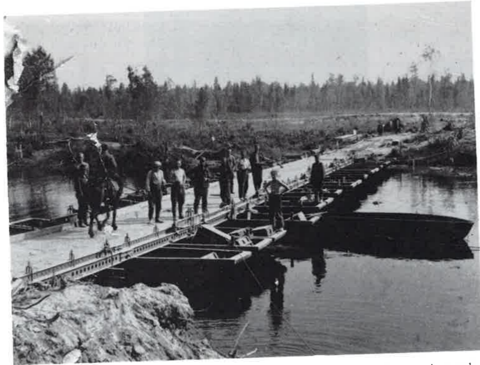
Pistojoen räjäytetyn sillan tilalle tehtiin ponttoonisilta. Varsinainen ylitys on jo tapahtunut. (Kuva Juho Ojalehto)
