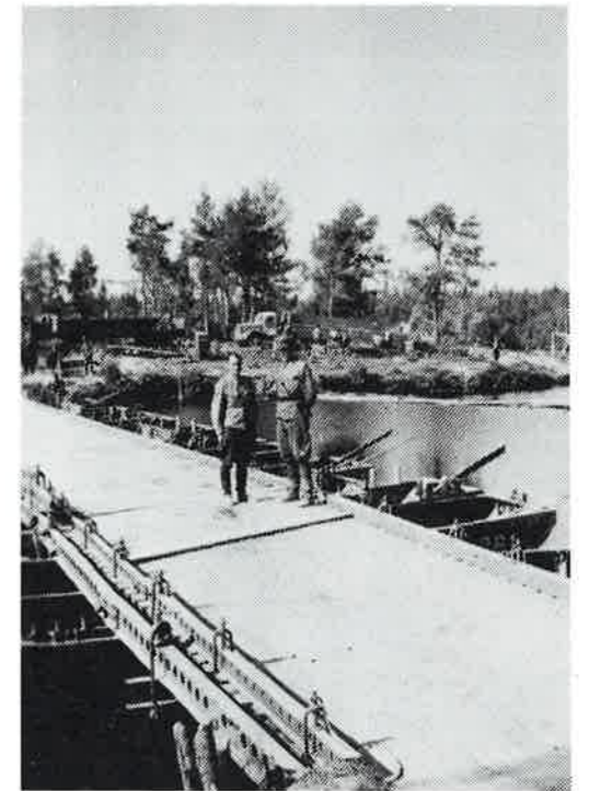
Ponttoonisilta Vuonnisen joella. Kuvassa oikealla siltakomppanian päällikkö insinööri kapt. Väre.
