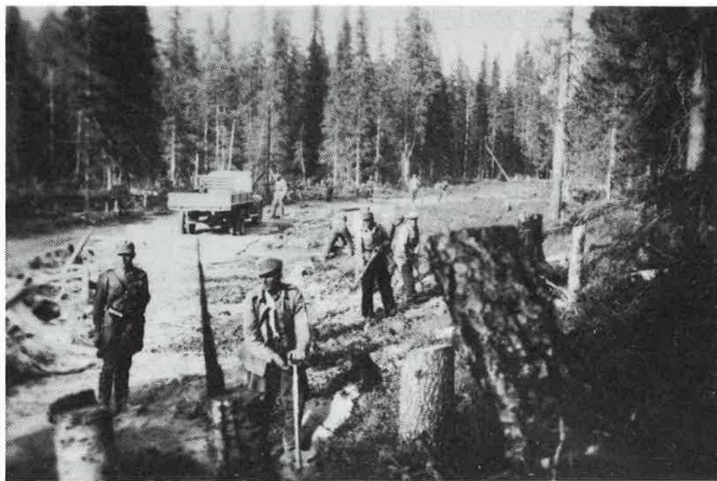
Röhöntien rakentamista ensimmäisen hyökkäyksen jälkeen.
