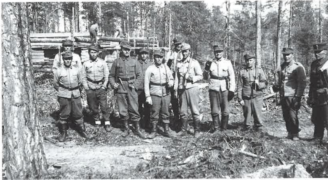
Asemasodan aikana tehtiin myös asevelitaloja. Rakennukset salvottiin rintamalla ja tuotiin hirsinä kotirintamalle sotainvalidin tai kaatuneen perheen käyttöön. Kestilässä yksi tällainen talo on Taipaleentielle pystytetty Pistomäki, joka rakennettiin Pistojoella. Sen ensimmäinen asukas oli sodassa sokeutunut Toivo Karioja. Tässä ollaan asevelitalon rakennuksella Uhtualla. (Kuvan om. Johannes Rahikainen).
