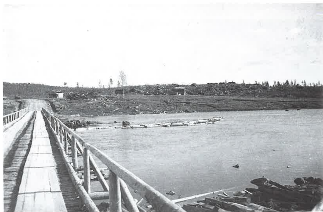
Pioneerit ovat rakentaneet uuden sillan venäläisten räjäyttämän tilalle. (Kuvan om. Ilmari Leinonen).
