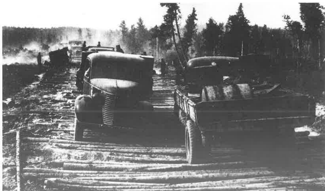
Kapulateie Korpijärvellä heinäkuussa 1941 metsäpalon savujen keskellä. Kapulateitä rakennettiin pehmytpohjaisille paikoille, joista piti päästä kulkemaan raskaalla kalustolla. Tulipalot vaikeuttivat ja suorastaan estivät etenemistä. Ne saattoivat syttyä tykistön ja heittimien ammuksista, mutta vihollinen syytti niitä myös tahallaan oman vetäytymisensä suojaamiseksi. (Kuvan om. Pohjan prikaati).
