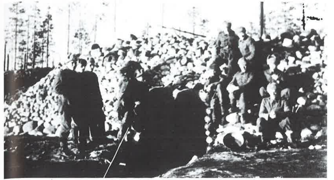
Kivillä päällystetty korsu Kuittijärven rannassa. Tavallisesti korsu kaivettiin maahan, seinät tehtiin hirrestä ja katto peitettiin maalla ja vahvistettiin useilla hirsikerroilla kestämään kranaatit. Tällä paikalla oli niin märkää, ettei kyetty kaivautumaan maahan. (Kuvan om. Reino Hyvönen).
