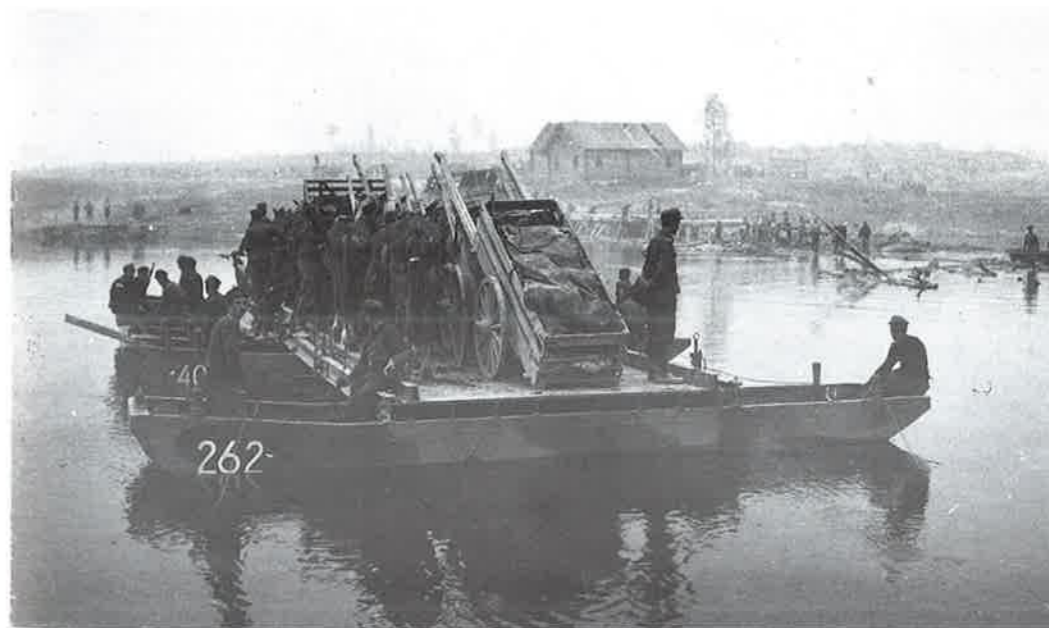
Tässä ylitetään kuuluisaa Pistojokea ponttooneilla. Näin vietiin yli jopa panssareita, ennen kuin ehdittiin rakentaa uusi silta venäläisten räjäyttämän tilalle. (Kuvan om. Ilmari Karppinen).
