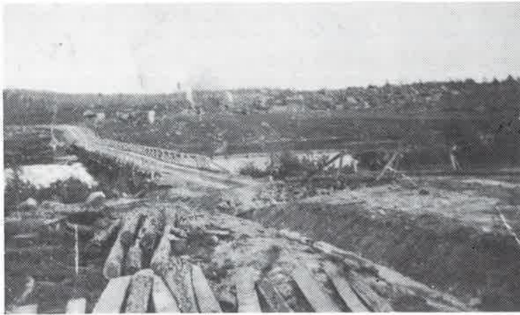
Uusi tie ja Sohjanan silta Kiestingissä. – Kuva Alpo Leppälä.
