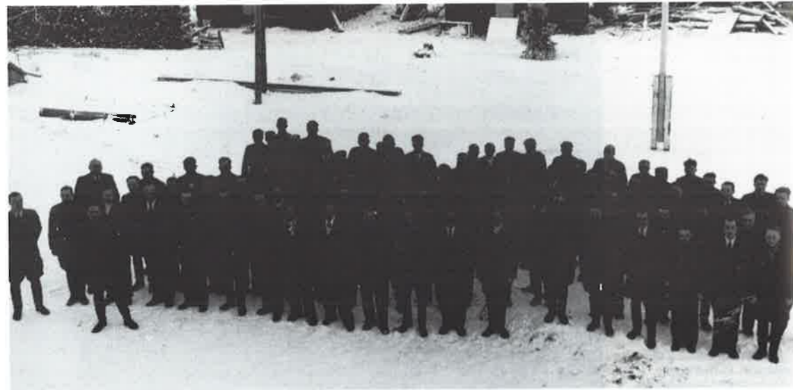
Talvisodan veteraaneja talvella 1941. Kuva otettu Jussilan katolta. Jussila ostettiin vuonna 1928 suojeluskunnan toimitaloksi. Talvisodan aattovuosina Jussilaa laajennettiin suurimmalta osalta talkoovoimin.
