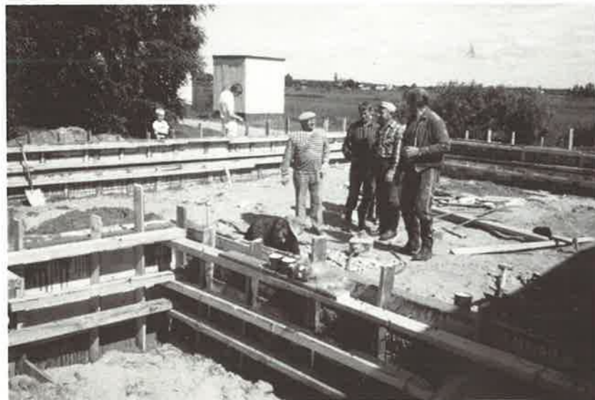
Sitten kesällä 1985 päästiin pitkällisen paperisodan jälkeen Kuntosali-Kerhohuoneen rakentamiseen. Rahoituksen pesämunaksi saatiin Lumijoen kunnalta 70000:-, Raha-automaatti YHD. 100000:- ja LC Liminka—Lakuedelta Punaisen-Sulan keräysvaroista 60000:-. Ruuvailin tekotalkoissa edessä Eino Raappana, joka poikansa kanssa toimi rakennuksen kirvesmiehenä; vasemmalta Yrjö Ollakka, Kalle Greus, Reino Särkioja, Erkki Laurila. Takana kunnan rak.mest. Eino Jakkula tutkimassa valun onnistumista.
