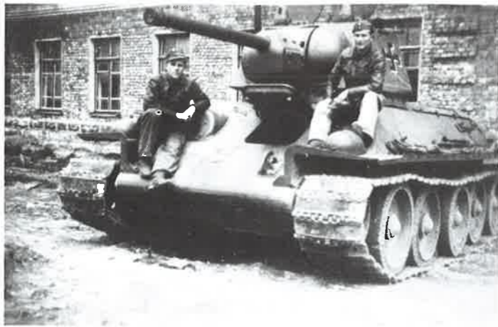
Kesällä 1941 sotasaaliiksi saatu panssarivaunu T-34 eli Sotka. Sotkaan eivät suomalaisten panssarintorjunta-aseet tehonneet. Vasta ontelokranaattien tultua käyttöön voitiin Sotkakin pysäyttää. Valtuista Sotkista muodostettiin panssarivoimiimme raskas panssarikomppania. (Martti Markus)
