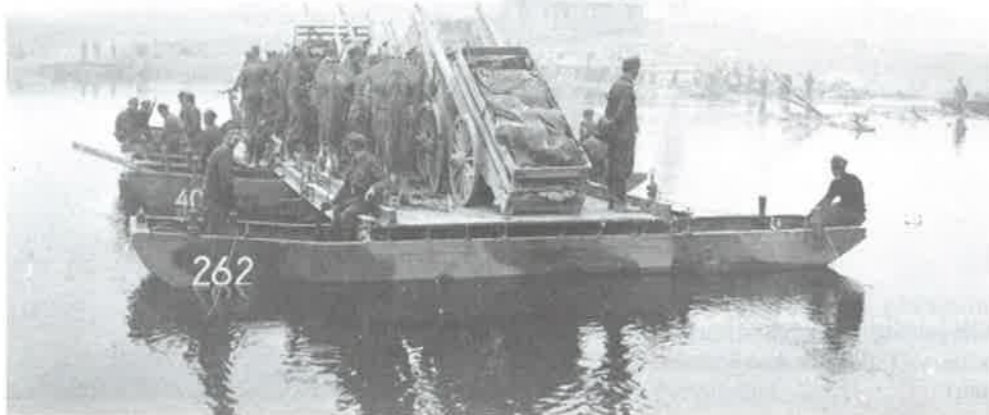
Vesistöjen ylitysjärjestelyt ovat pioneerien toiminta-alueita. Kuvassa ponttonilossi Pistojoella. (Valokuvaamo Tyrväinen)
