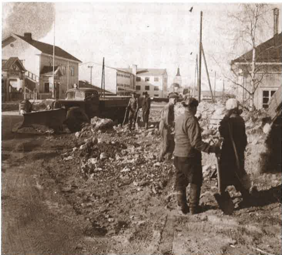
Sodan aikana vaurioituneiden teiden kunnostaminen siirtyi 1950-luvulle. Kuvassa tietyömaa Kajaanintiellä lokakuussa 1952.
