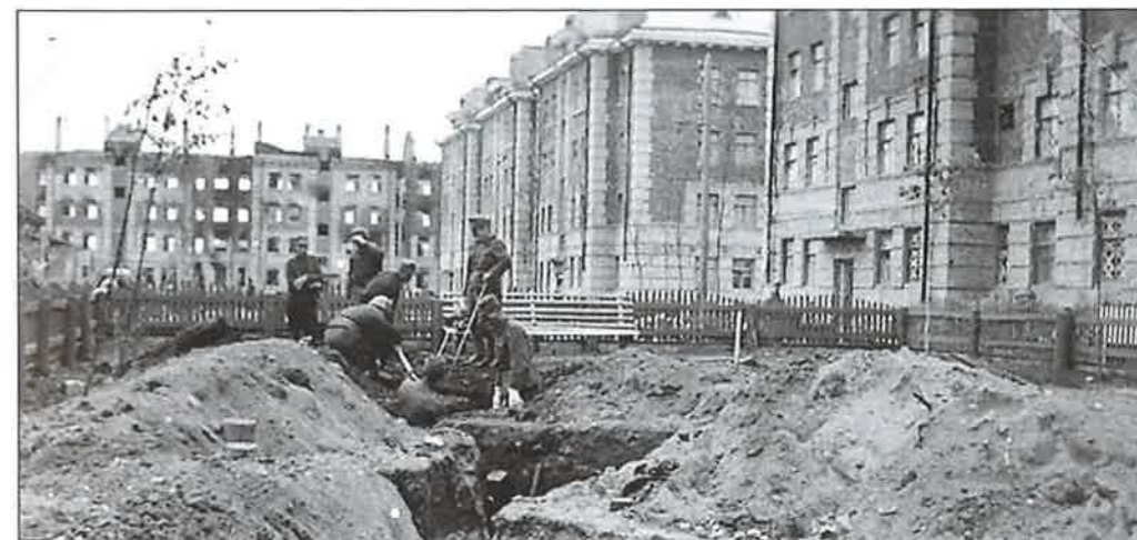
Oikealla oleva tiilirakennus oli 4./JR 60:n majapaikkana.
