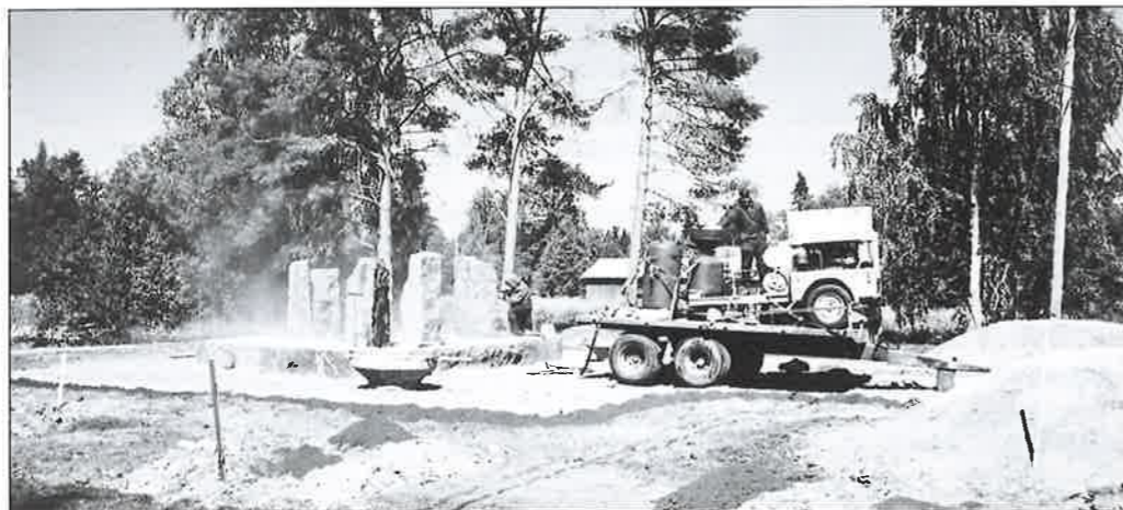
Paavo Rankinen käytti hiekkapuhallusta veteraanipuiston kivien puhdistamiseen.
