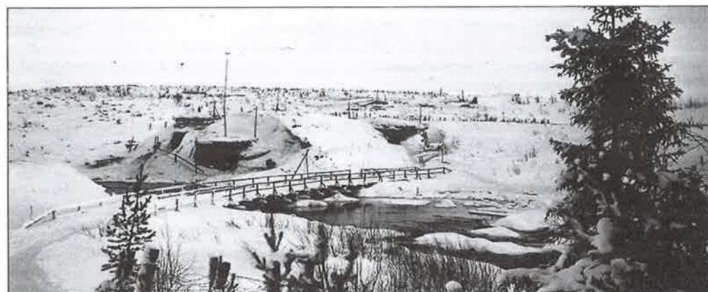
Saaren pohjoispäähän oli rakennettu ponttoonisilta.
