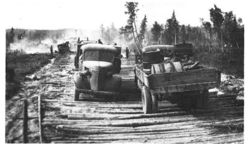
Päätie Uhtualle vahvistettiin vuonna -41 pehmeikköjen yli puiden rungoilla kapulatieksi.
