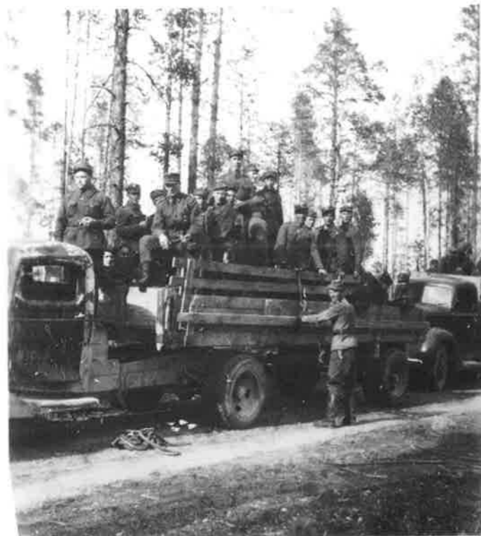
JR 11:n siirto Uhtuan Puumalankankaalta Kiestinkiin. Autoa kuljettaa kuvan omistava Olavi Kallio.
