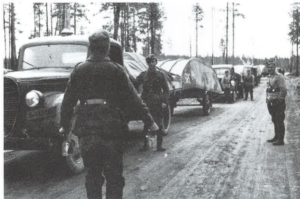
Tässä viedään ponttooneja Sohjanajoelle pioneerien pikasiltaa varten vuonna 1941. Kuvan om. Kauko Laakko.
