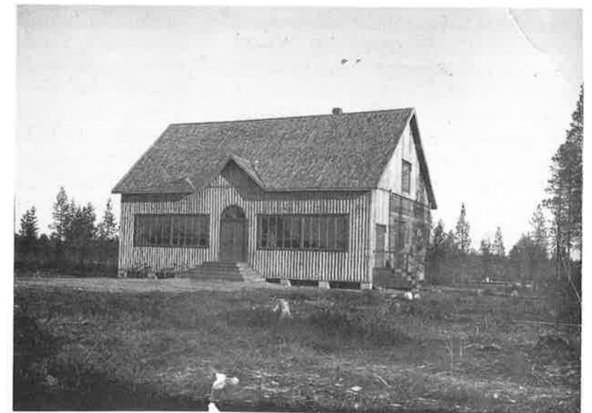
Suojalinnan ensimmäinen rakennusvaihe. Kuvan om. Eino Riekki.
