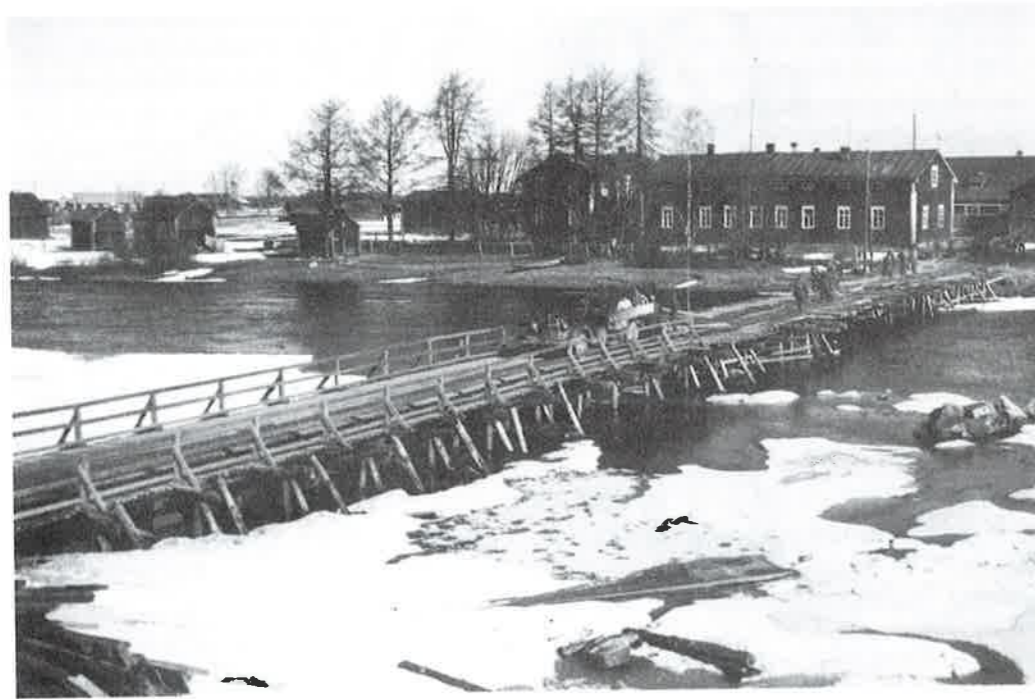
Saksalaisten 30.9.1944 räjäyttämän Ijoen sillan viereen rakennettiin väliai- kainen pukkisilta. Kuvan om. Kauko Laakko.
