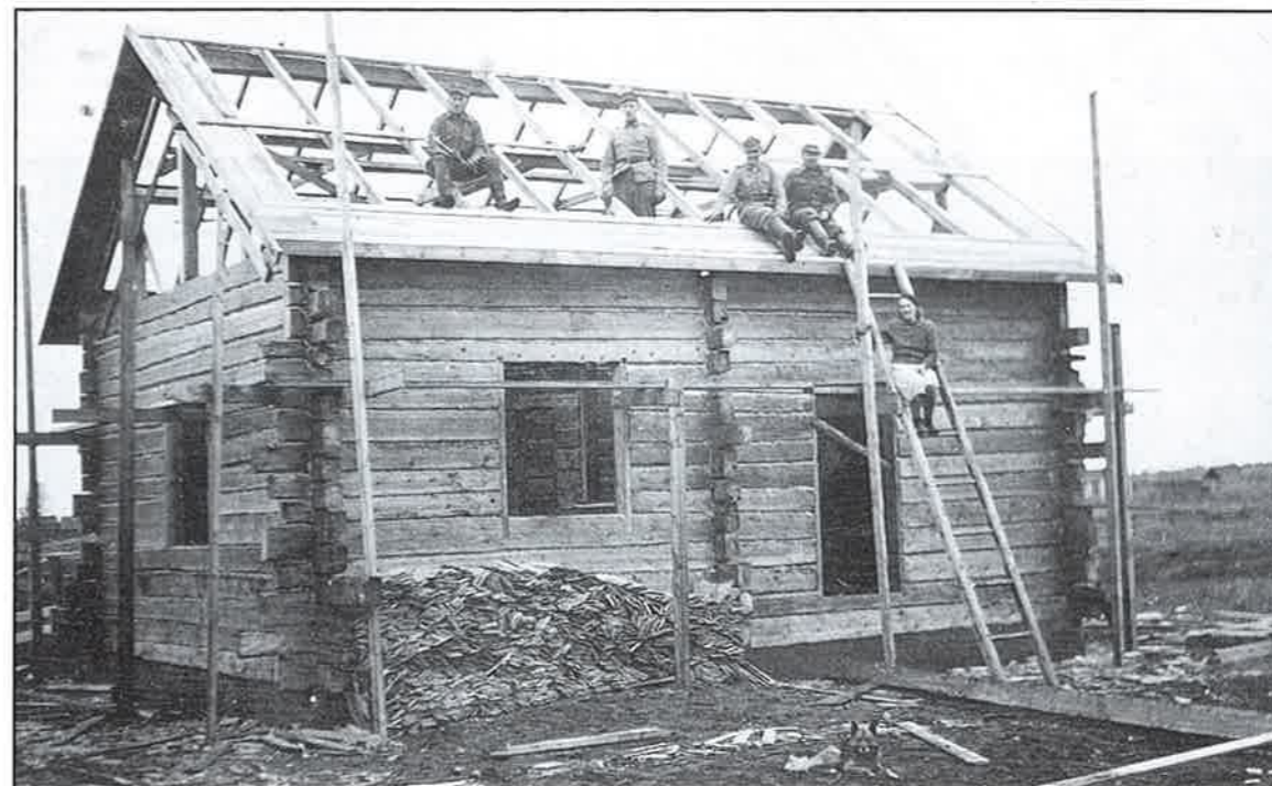
Lääkintäkomppania 24:n miehet salvasivat soteleski Edla Tuikkalalle asevelitalon Eldankajärven rannalla. Hirret kuljetettiin junalla ja kuorma-autolla Pyhäjoen Rautiperälle ja sen pystyttivät Matti Tuuttila, Väinö Sillanpää, Erkki Kestilä ja Väinö Pyhälä. Tikapuilla Edla Tuikkala. Vastaavanlaisia asevelitaloja tehtiin muillekin. (Kuva Erkki Kestilän)
