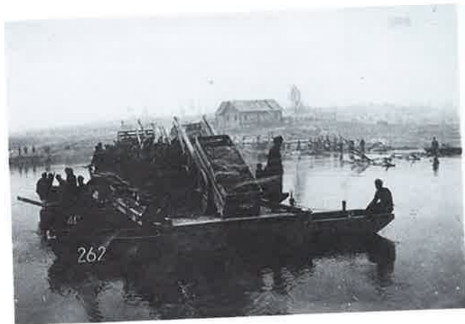
Pistojoen ylitys ruuhien päälle rakennetulla lauttalla. Materiaalin kuljetus oli erämaissa vaikea tehtävä. Kuva Erkki Penttilän albumi.
