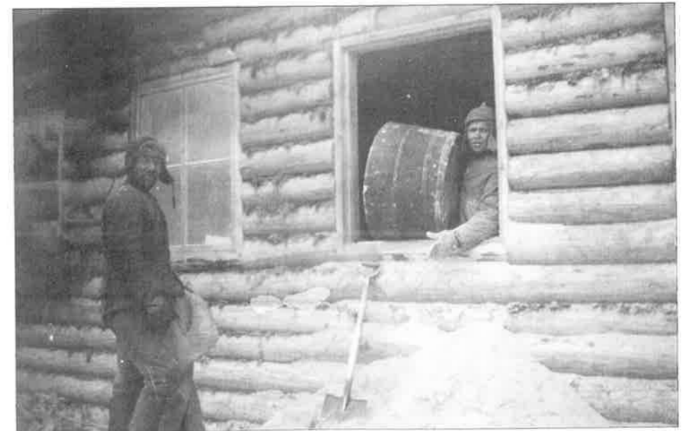
Venäläisillä vangeilla teetettiin töitä. Kuvassa olevat vangit olivat rakennustöissä Repolassa. (SH)
