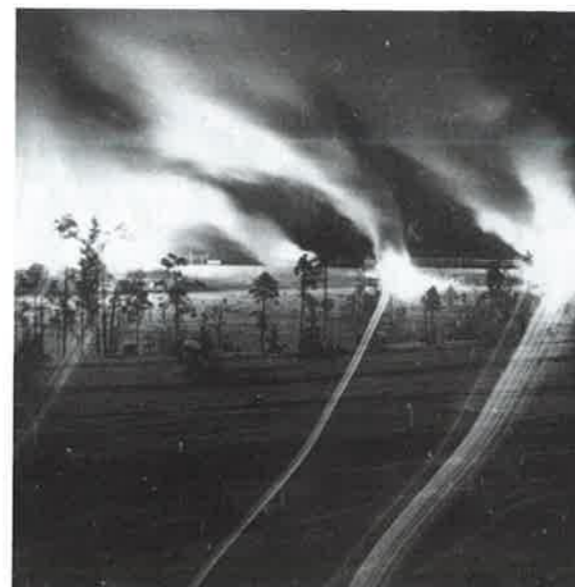
Tukikohdan rakennukset on sytytetty tuleen.
