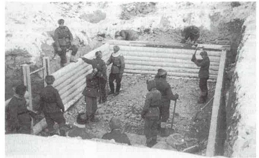
Korsun tekemisen taidon osasivat monet miehet, hirsitalon tekijöitä silloin löytyi enemmän kuin nykyään, ja suomalaisten korsu oli oikeastaan maan sisään rakennettu hirsimökki. Kuva Karjalan kannakselta talvisodan aikaan.
