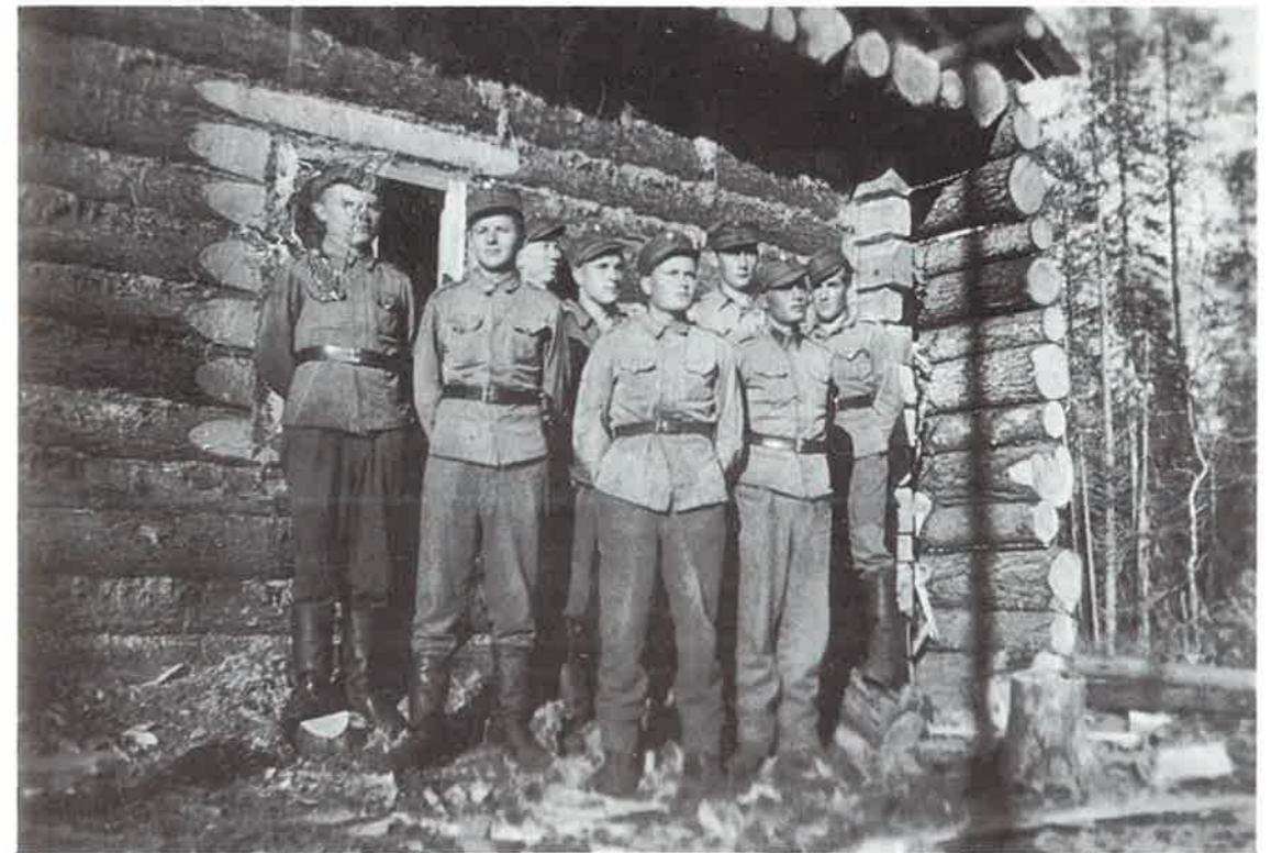
1/JR 11:n krh-joukkueen maanpäällinen korsu Kuittijärvellä 1942. Kuten kuvasta näkyy, yksi seinä, vihollisen puoleinen, on tehty kaksinkertaisesta hirsikerroksesta, joiden väliin laitettiin kiviä. Katto oli myös vahvistettu. Yleensä korsut tehtiin maan alle, mutta tämä oli käyttökelpoinen näissä olosuhteissa. Seinä kesti suorasauntauistykin osuman, kuten käytännössä todettiin. Matti Kauppi 4. vasemmalta.
