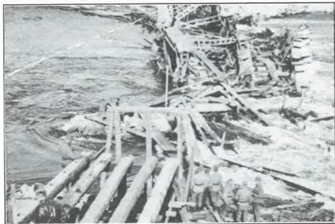
Käkisalmi-Viipuri rautatien Vuoksen ylittävä silta kesällä 1941. Pion.P 13 teki siltaromun päälle tilapäisen sillan. - Kuvan om. Toivo Kaiponen.
