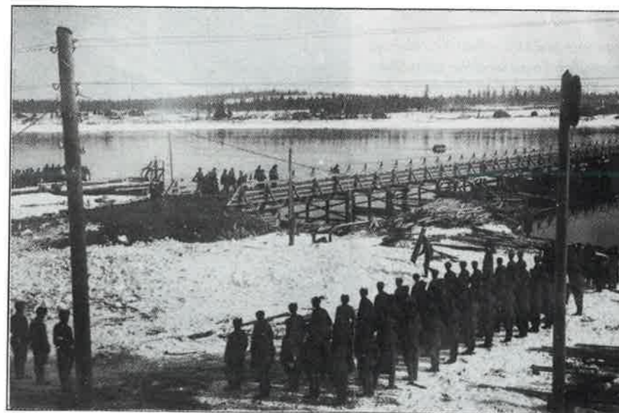
Syvärin ylittävän Vosnesenjan sillan valmistumista juhlietaan sillaparaatilla. - Kuvan om. Hugo Karhu.
