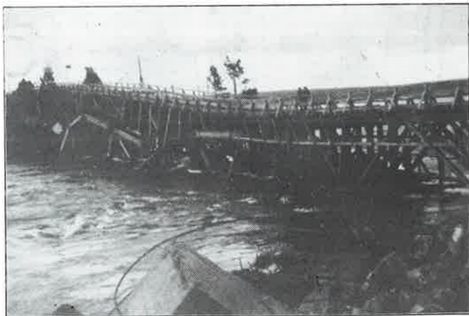
Vuoksen tilapäissilta valmiina. - Kuvan om. Toivo Kaiponen.
