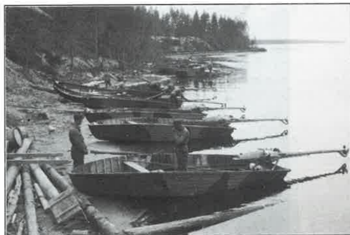
Syöksyveneitä tarkistetaan. Syöksyveneet kuuluivat ponttoonikomppanioiden kalustoon ja niitä ajoivat maihinnousuissa erikoiskoulutetut pioneerit. - Kuvan om. Eeva Oilinki.
