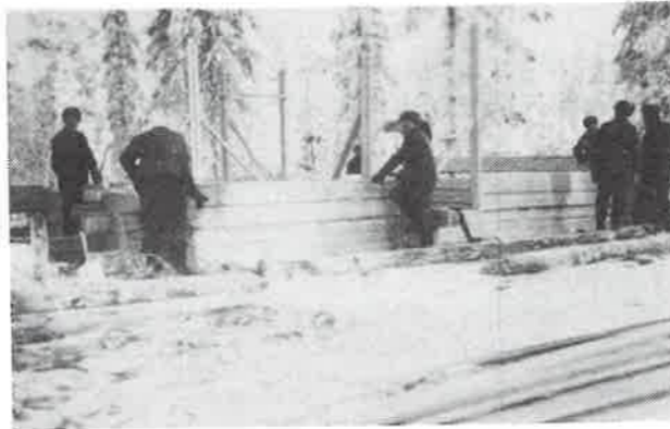
Asevelitalon veistotyömaa Uhtualla talvella 1942-43. Vihantiin tällaisen työn tuloksia tuli 4. (Kuva Urho Lämsä)
