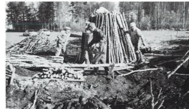
Hiilimiilun rakentaminen syksyllä 1988.
