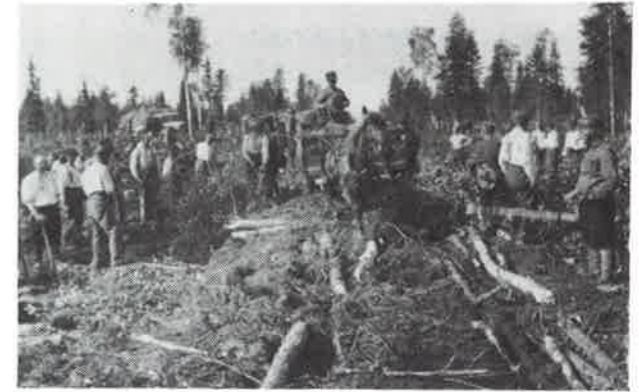
Kulku oli paikoin vaivalloista. Ajomiehen taidot ja hevosen voimat olivat usein koetuksella. (Kuva Urho Lämsä)
