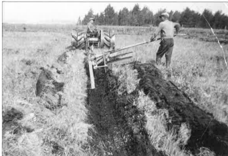
Kun ojan kaivaminen aloitettiin, piti siivulle antaa suunta. Kuvassa Toivo Lähdesmäki kääntämässä suo-ojan aloitussiivua, jonka jälkeen traktorin kuljettaja pystyi jatkamaan ojan tekoa. Kuva ennen talvisotaa.
