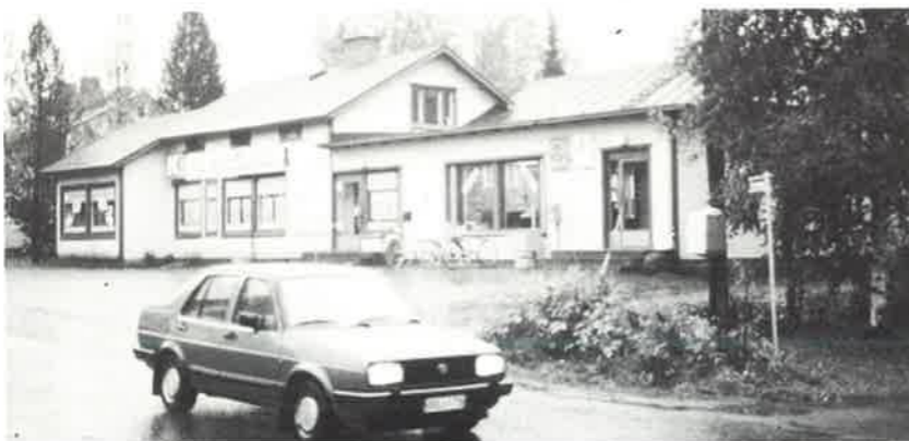
Toisessa apteekkirakennuksessa on toiminut kauppaliikkeitä, posti ja turkislevyttämö.
