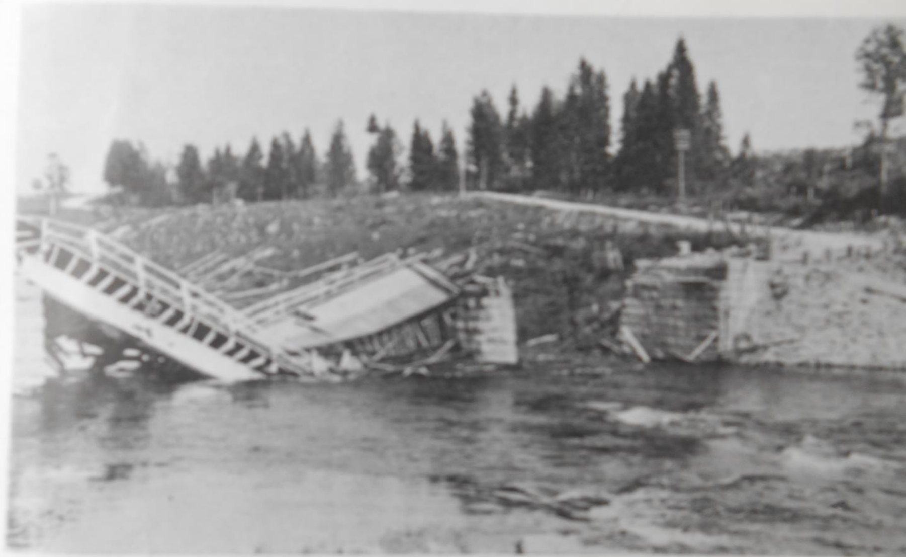
Venäläisten räjäyttämä Häme kosken maantiesilta.
